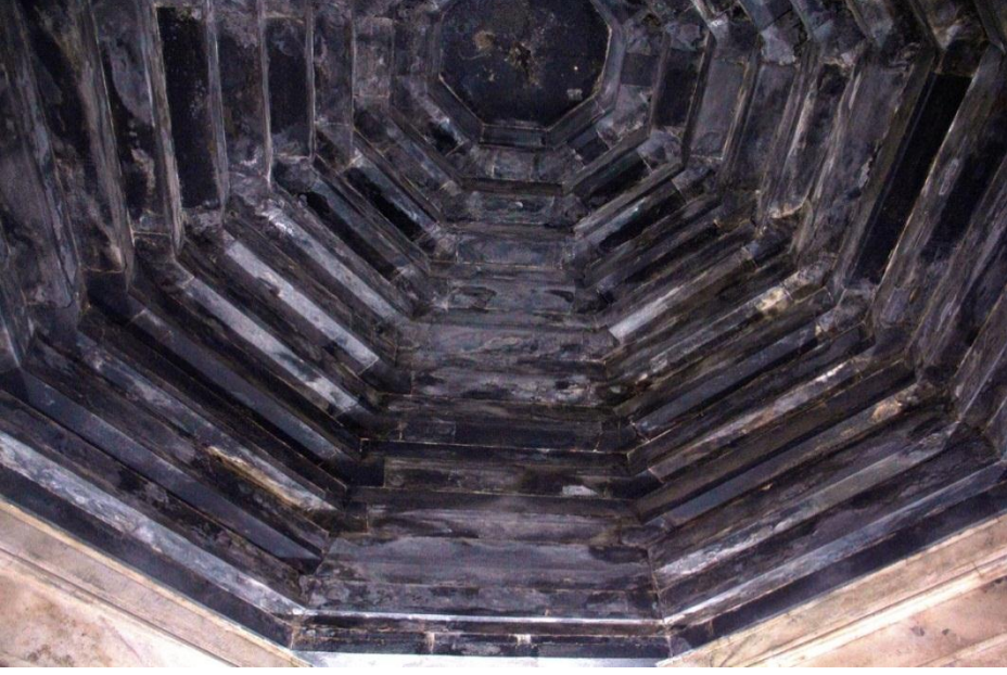
İçten içe çıkma destek tekniğiyle tavan, Kaynak: Shajjad Hossain, 2015
